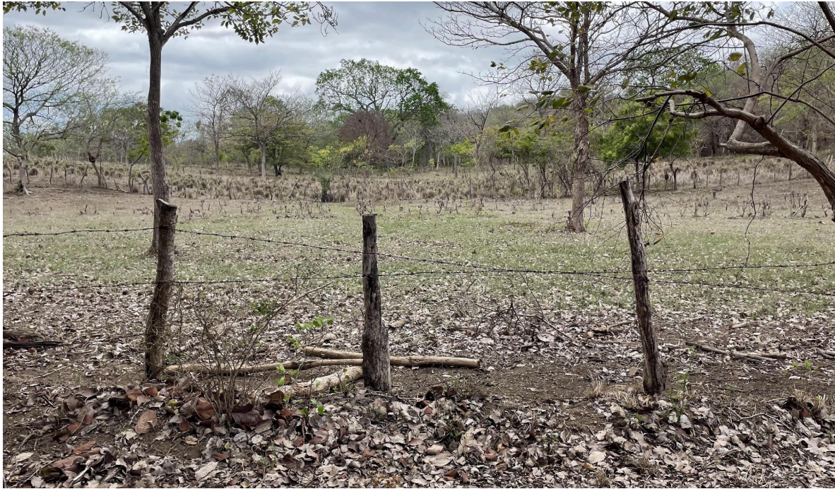
Anexo 25. Cercado limítrofe en mal estado.
