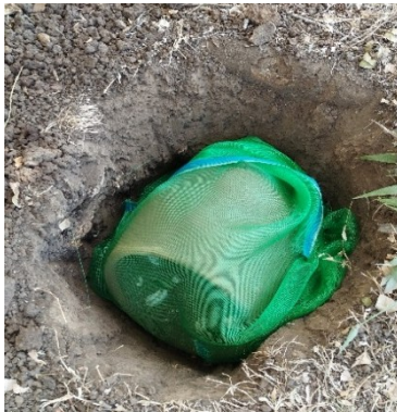
Colocación de la tela malla
