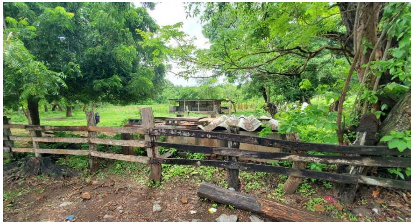
Imagen 04. Silo bunker de 40 toneladas.
